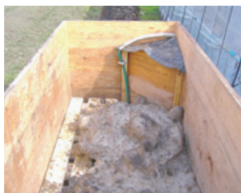
貯雪槽の中。すのこを敷いて雪と冷水を分ける
